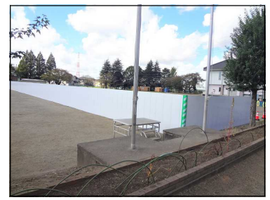
【グラウンド工事に伴う仮囲い】
